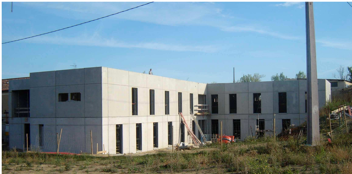
Le gros œuvre de la résidence sociale est désormais terminé
