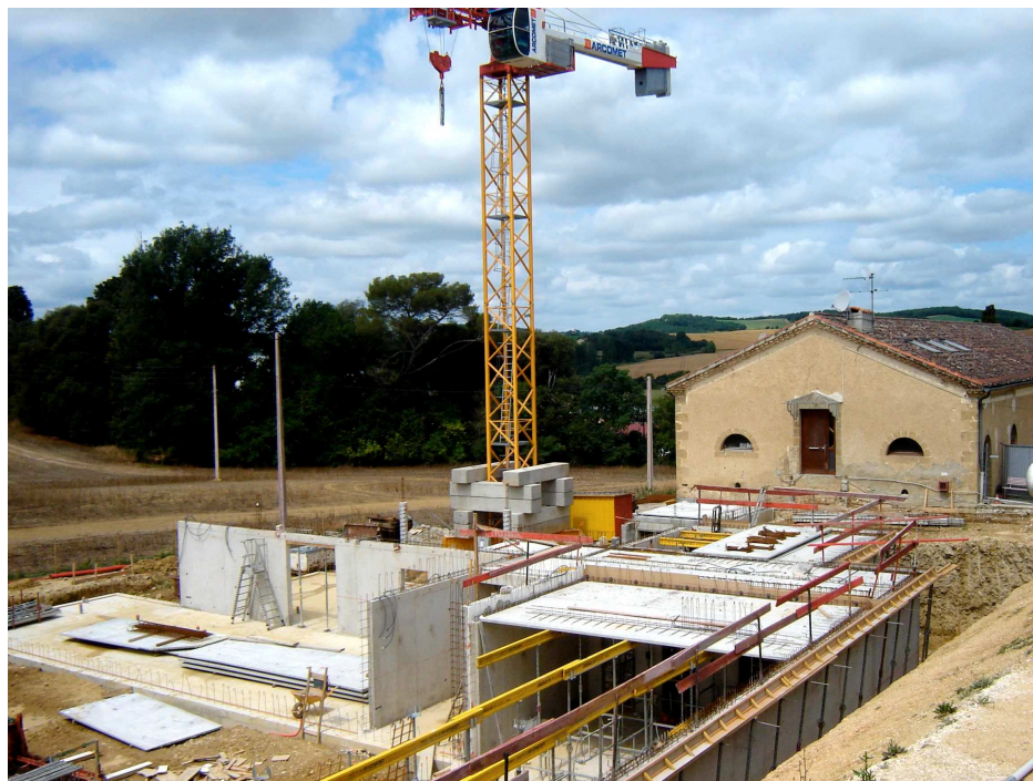
Construction des murs de la future résidence sociale
